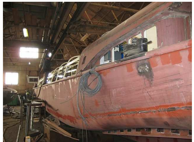
De bakboordszijde ter hoogte van het machinehuis
