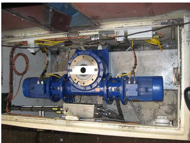
De motoren voor de bediening van de 'roerstand' van het schroefhuis.
