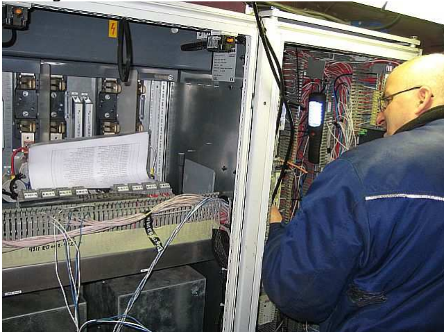
Kasten vol met plc's houden productie en gebruik van energie in optimale balans
